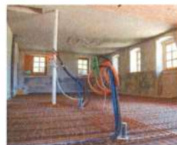
Rohbau: Hier wurde ordentlich Hand angelegt. Foto: Visual Kings
