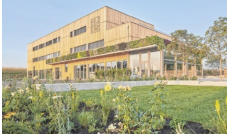
Das neu errichtete Gebäude ist ein absoluter Hingucker.
