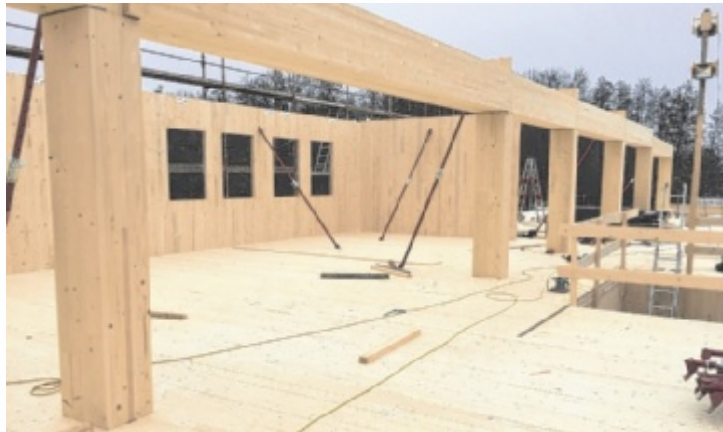
Der Baustoff des neuen Hauses stammt aus heimischen Wäldern.
